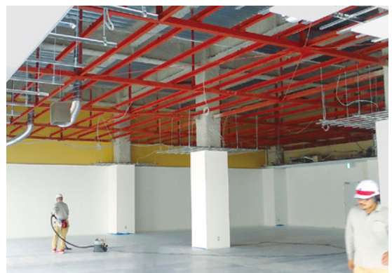
建築改修工事
