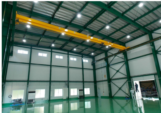
組立工場（大型装置用）
