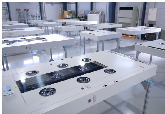
エアーシャワー組立作業
