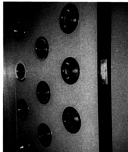
図4 帯電防止樹脂ノズル(新タイプ)
